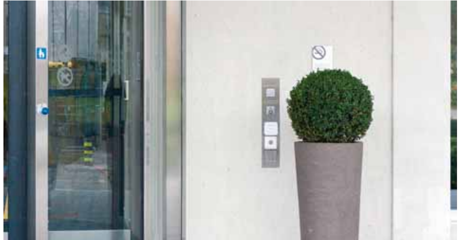
Zutrittskontrolle am Haupteingang der Klinik Hirslanden Zürich über einen XS4 2.0 Online-Wandleser von Salto.
