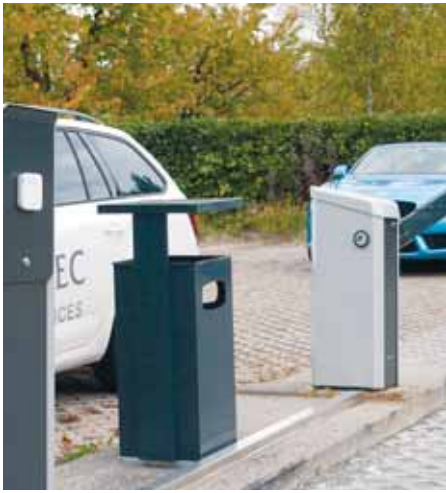
Zufahrtskontrolle für einen Parkplatz der Klinik Hirslanden Zürich über einen XS4 2.0 Online-Wandler.
