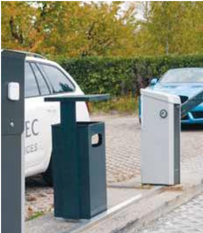
Contrôle d'accès pour un parking de la clinique Hirslanden à Zurich via un lecteur mural en ligne
